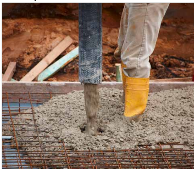
Betonierung einer Schmidt-Elementdecke
